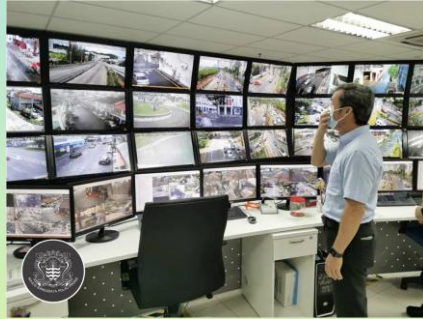
Pemasangan CCTV di seluruh negeri. Sasaran 5,000 unit dipasang menjelang 2030
